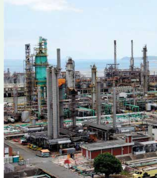
Implantación de tecnología ABACO en refinería Landulpho Alves (Brasil). Implementation of ABACO technology in Landulpho Alves refinery (Brazil).
