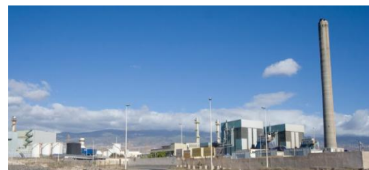
AAI de la C.T. Granadilla de Abona y sus dos ciclos combinados autorizadas por INERCO (Tenerife)
