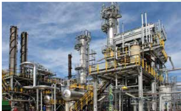
Estudios de Seguridad Industrial para el sector energía y oil&gas. Industrial Safety studies for energy and oil&gas sectors.
