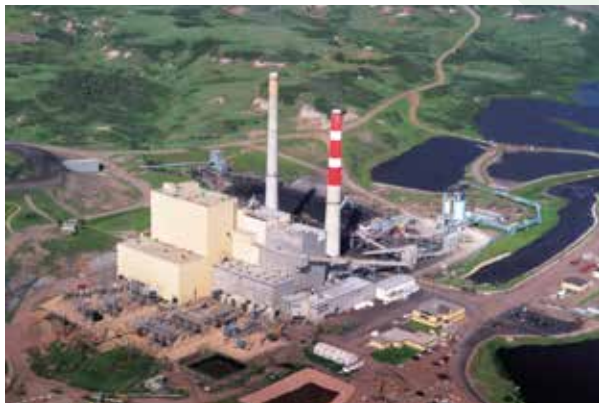
Supervisión online del sistema ABACO instalado en la central Battle River para ATCO Power.
