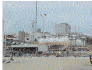
Nueva Planta de Cepsa Elf Gas en San Roque
