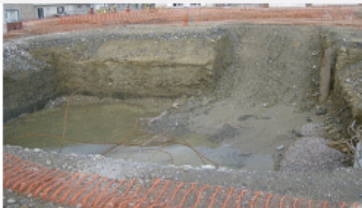
Excavación del suelo contaminado
