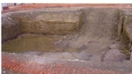
Excavación del suelo contaminado
