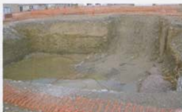
Excavación y envío a vertedero
