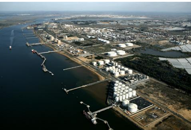
Ampliaciones de Refinería La Rábida, ENAGAS, CLH y DECAL autorizadas por INERCO (Palos de la Frontera, Huelva)
