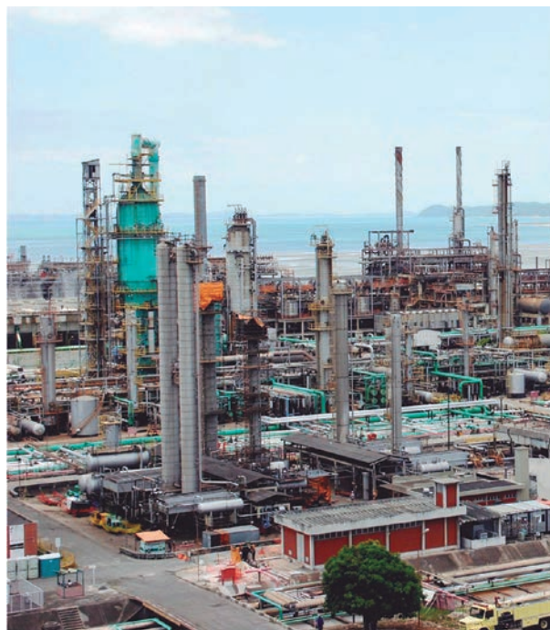
Implantación de tecnología ABACO en la refinería Landulpho Alves (Petrobras). Implementation of ABACO technology in the Landulpho Alves refinery (Petrobras).
