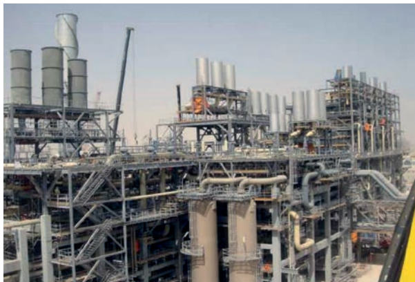
Tecnología acústica para plantas energéticas. Acoustic technology for power plants.
