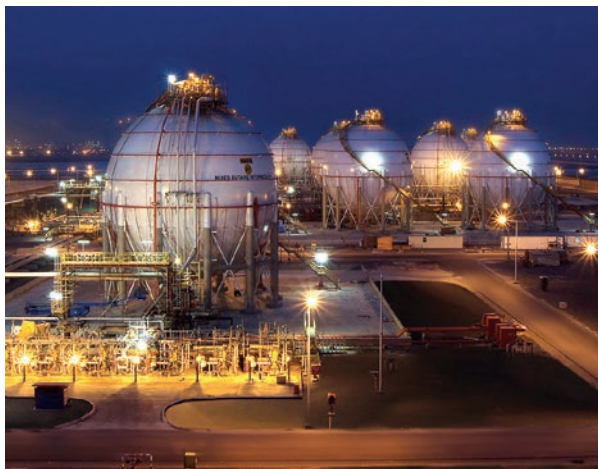
Adaptación de la gran industria a la normativa Seveso. Adaptation of the chemical industry to the Seveso regulation.
